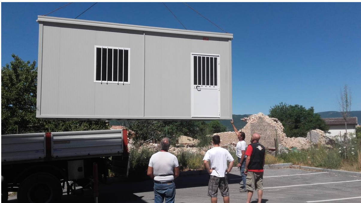
Consegna modulo abitativo presso Comune di Frascaro
